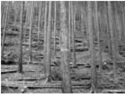
▲間伐木を利用した土留工の設置(牧野)
