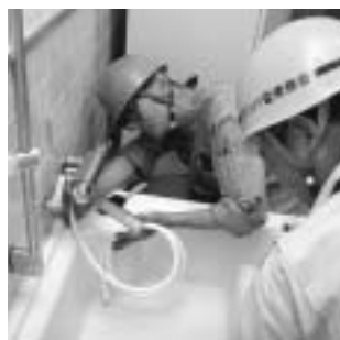
▲教室のシャワーを修理
