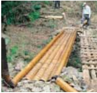
▲新しく架け替えられた木橋
