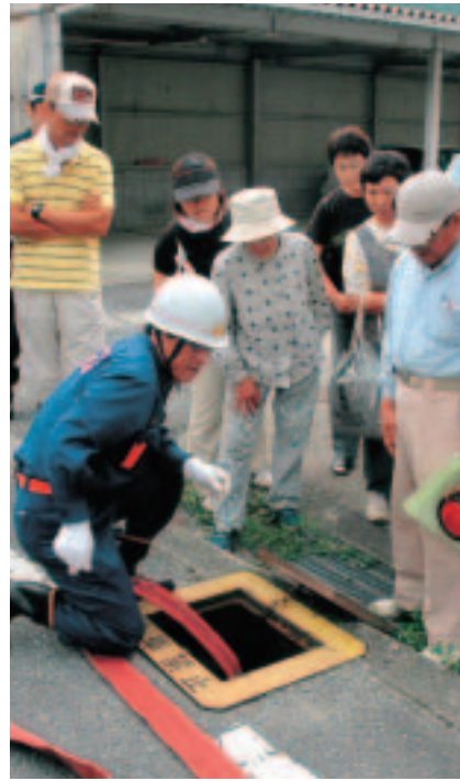
▲消火栓の操作説明
