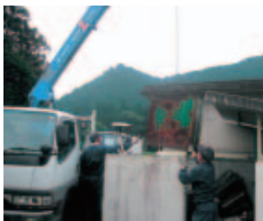
▲焼却炉の撤去作業
