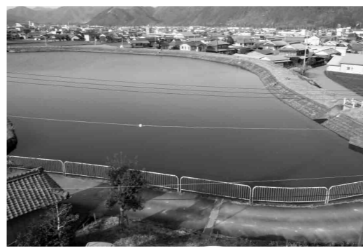
耐震診断を受けるため池
