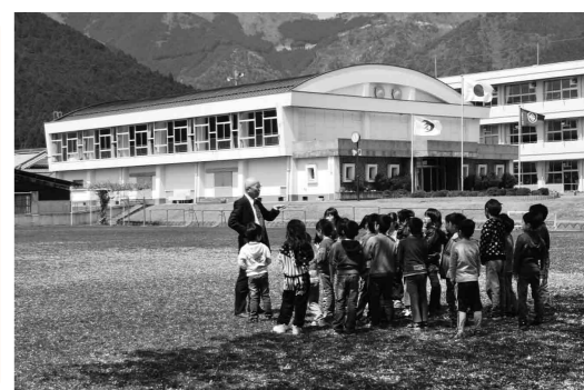
耐震補強が待たれる杉小体育館
