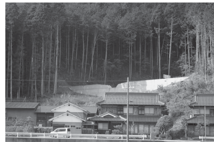
命を守る砂防えん堤 — 熊野部地区 —
