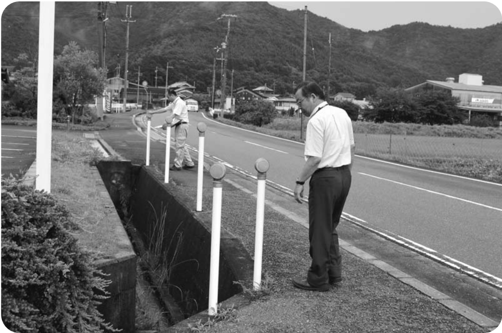
舗道を拡幅してほしいという集落要望を受けて、危険箇所転落防止柵を設置します
