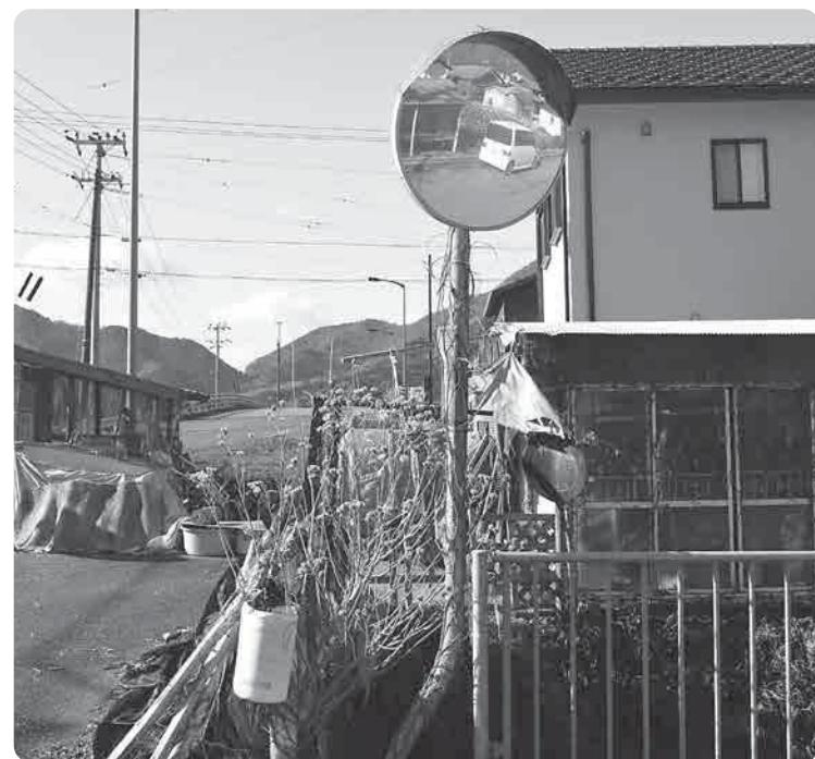
急がれる安全点検
