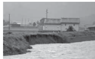
▲濁流で浸食された川岸(豊部)
