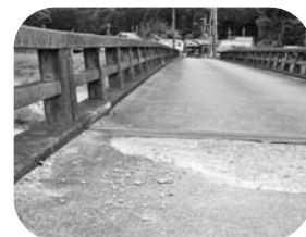
観音寺橋 — 加美区 —
