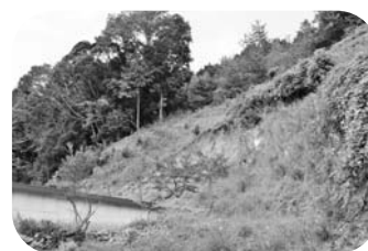
治山工事 — 奥中 —
