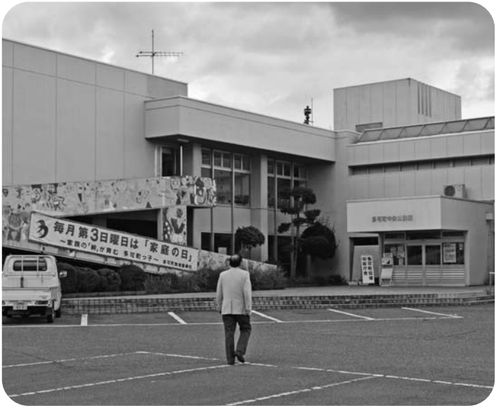
耐震診断中の中央公民館
