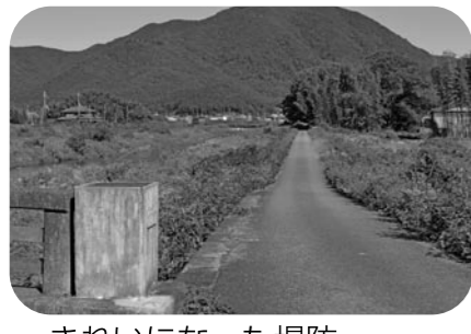
きれいになった堤防 — 高東橋付近 —
