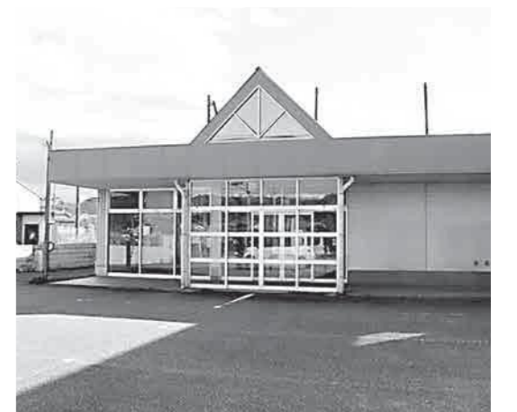
地域で運営 公設コンビニ -ふれあいマート(小野市)-
