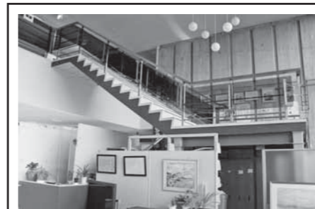
中プラザ(旧中央公民館) 施設の老朽化、バリアフリー化されていない
