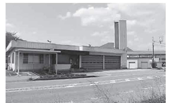
防災倉庫になります - 旧多可消防出張所 -
