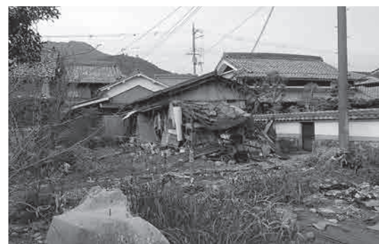
増える危険空き家
