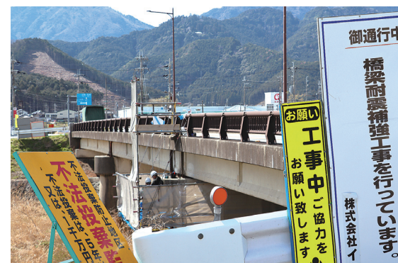
工事中の月ヶ花橋
