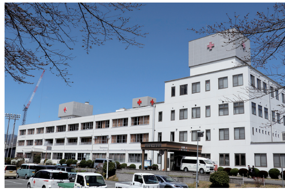
老朽化が進む多可赤十字病院
