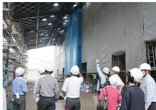
建設工事が順調に進む多可中学校
