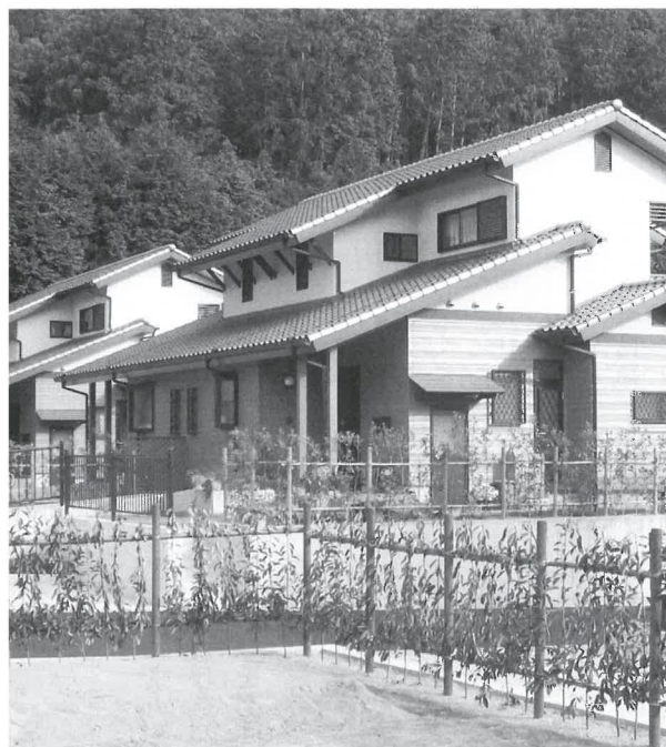
新しくなった八千代区の町営住宅
