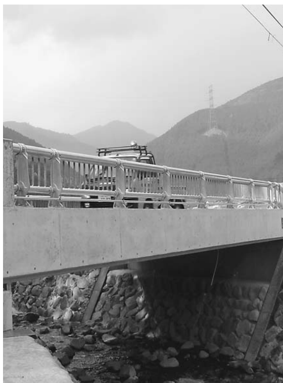
新しく完成した棚釜橋(加美区棚釜)
