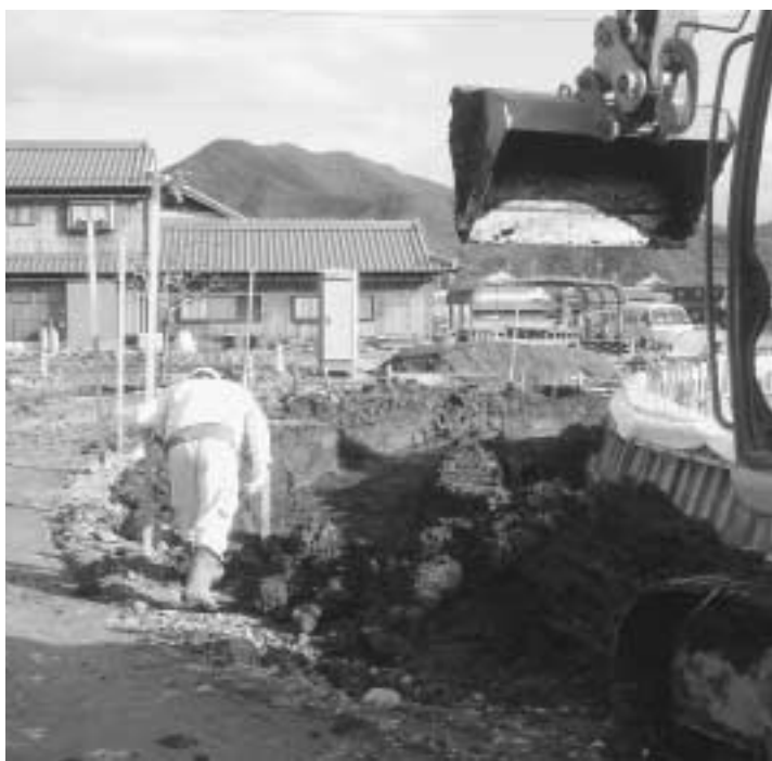
今日も進む道路工事（中区中安田）
