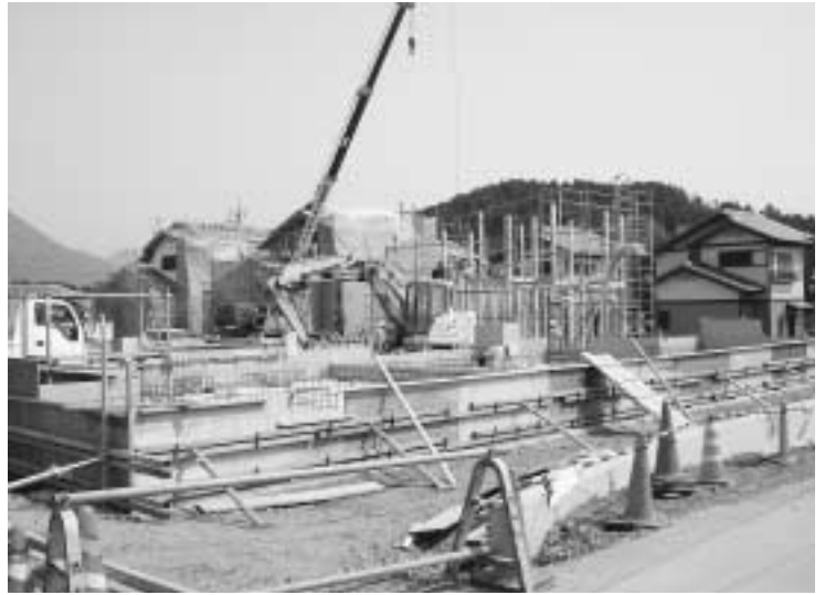
建設中の奥中団地
