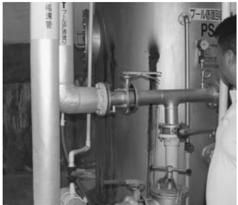
腐食がめだつ温水プール
