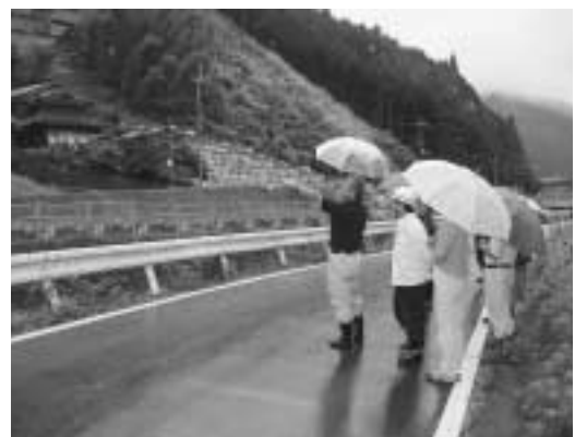
復旧工事が完了しています
