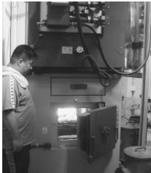
チップボイラーでお湯を沸かします
