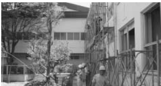
耐震補強も特例債で — 中町南小学校 —
