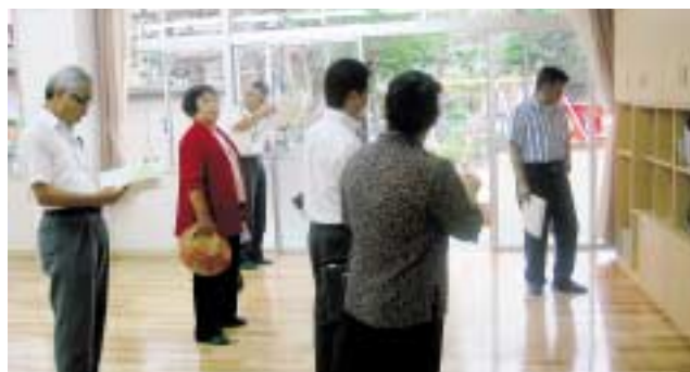
改修後の遊戯室を調査 - みどり保育所 -
