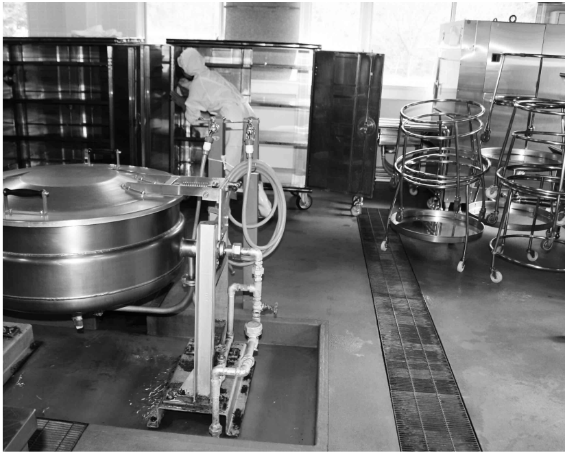
老朽化が進む給食センター — 八千代給食センター —
