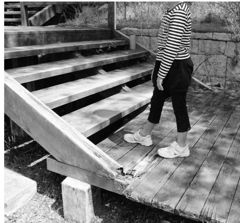
古くなった階段 ー余暇村公園ー
