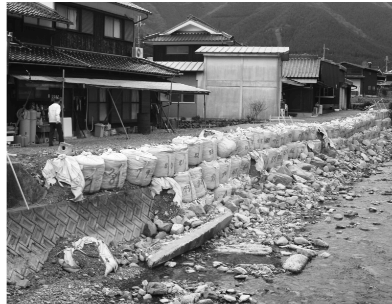
復旧が急がれる災害現場 -多田川-
