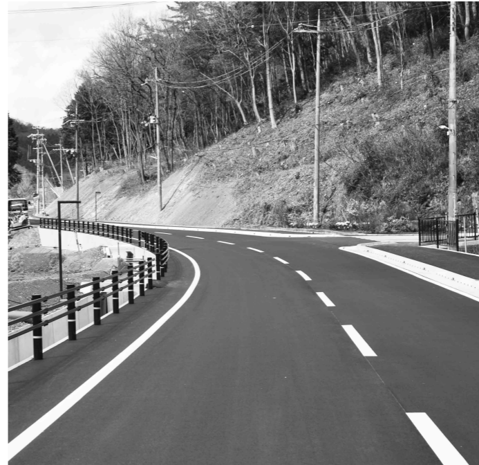
特例債で整備された八千代5号線 ー中野間ー
