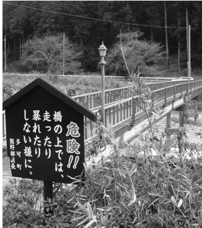
老朽化が進む熊野部の歩道
