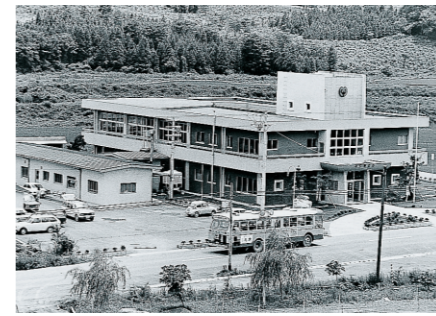
▲昭和44年6月に完成した旧加美町役場
