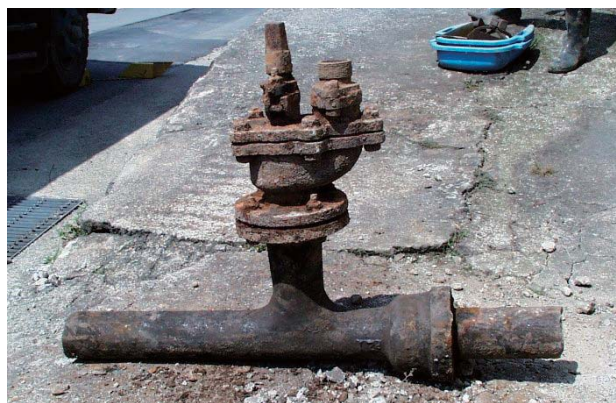
東山消火栓（東山公会堂所蔵）
