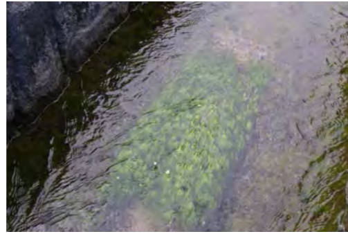
(川西) 水路を整備する際に、梅花藻が絶えないようにと、溝底の一部をコンクリートせず自然の川底を四角く残し、梅花藻の根を残しました。
