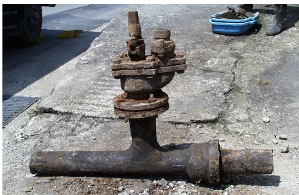
東山消火栓（那珂ふれあい館所蔵）
