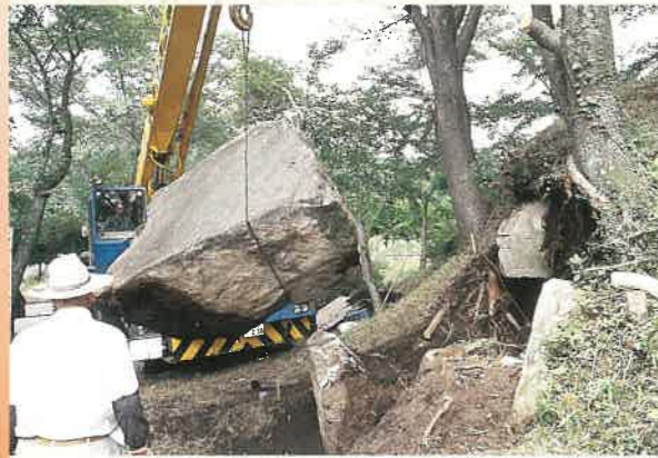
▲ クレーンによる天井石の除去作業
