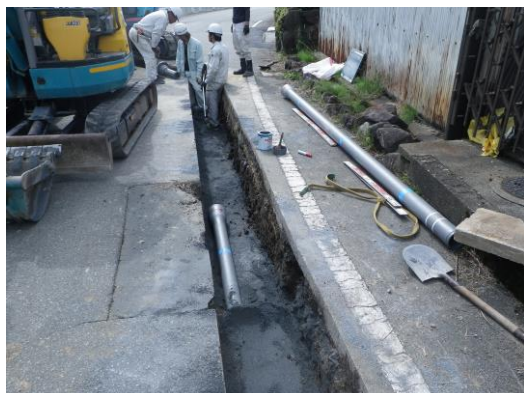
ダクタイル鋳鉄管への布設替え工事の様子
