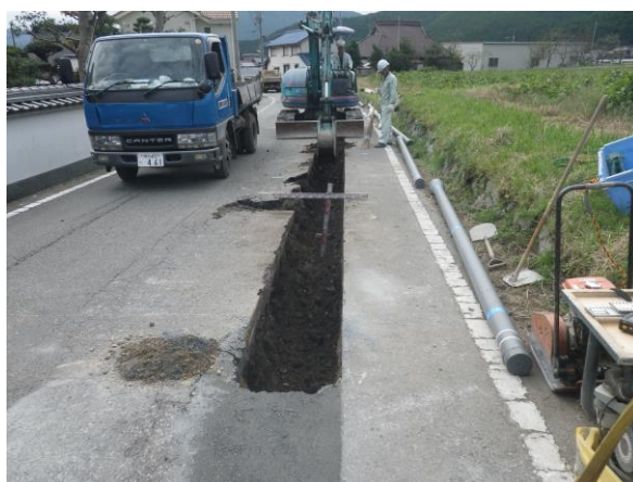
ダクタイル鉄管への布設替え工事の様子
