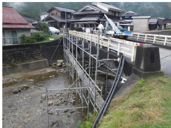
水管橋架替工事の様子
