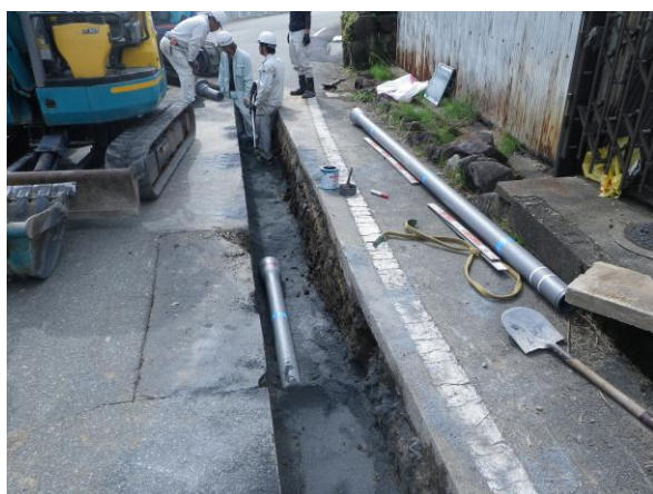
ダクタイル鉄管への布設替え工事の様子
