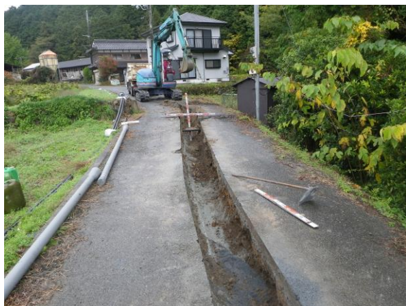
老朽管更新工事の様子
