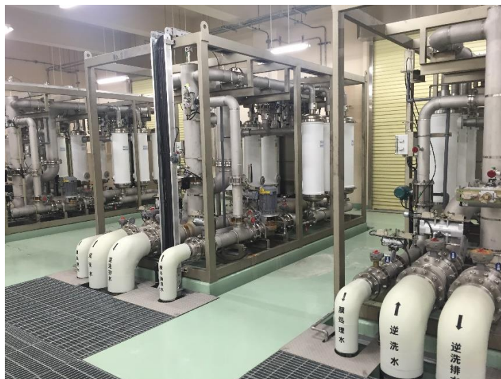
岸上浄水場の膜ろ過設備（中区岸上）
