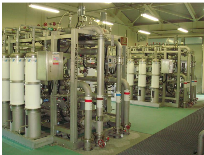
豊部浄水場の膜ろ過設備（加美区豊部）
