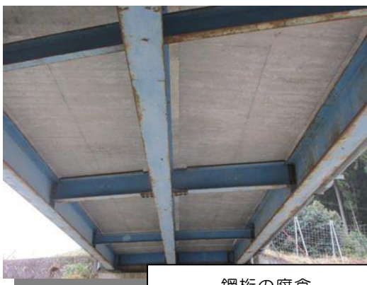
鋼桁の腐食
