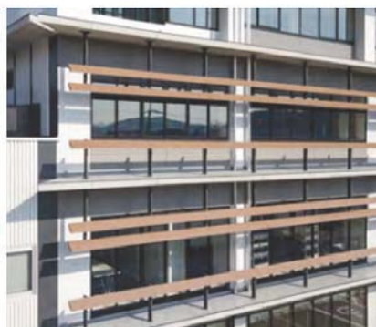
[日除けのためのルーバー]
