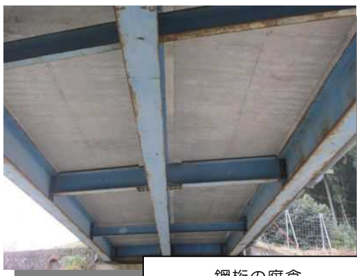
鋼桁の腐食
